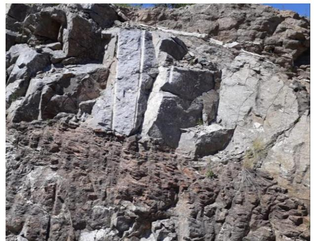
Fig. 5: Altura en la fotografía: 18 m. Talud EG 25 (31° 32.213' S – 64° 28.866' O). Factor de perturbación D diferenciado.
