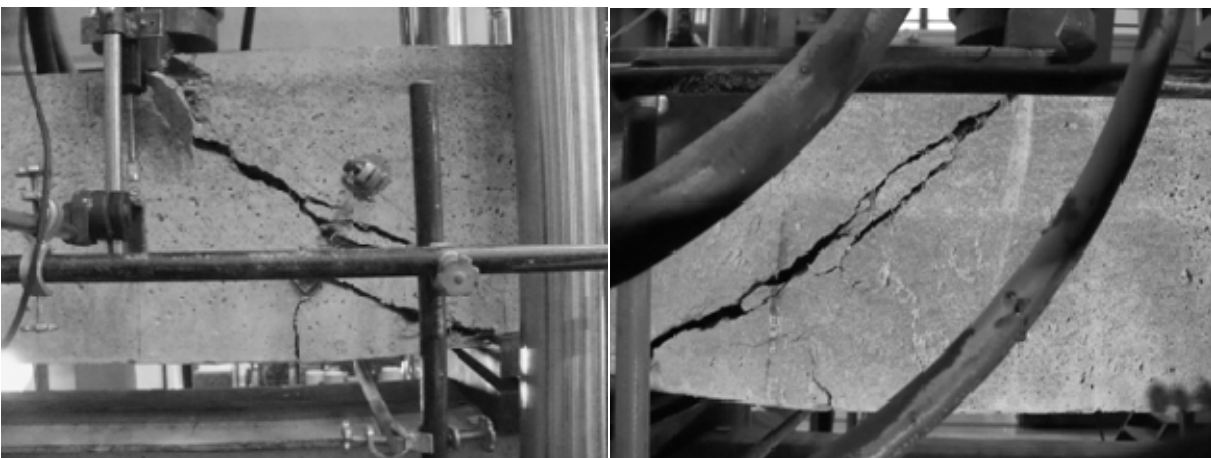
Figura 6: Estado final de la Viga 2 reparada y reensayada a rotura, Frente y Posterior.
