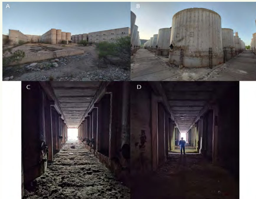
Ex Bodega del Estado Provincial. A) Vista panorámica del área de estudio, B) vista del segundo piso de la estructura mostrando los silos utilizados para almacenar vino, C y D) pasillos del subsuelo en donde los murciélagos habitan, donde se observa gran acumulación de guano. Fotografías: Álvaro Galbán
