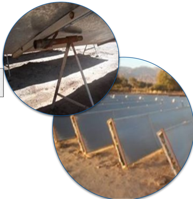
Figura 2: Banco de colectores. En primer plano la boca de entrada de aire ambiente.
