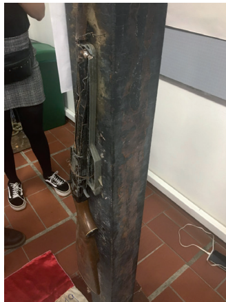
Fig. 3. Detalle de viga de hierro.
