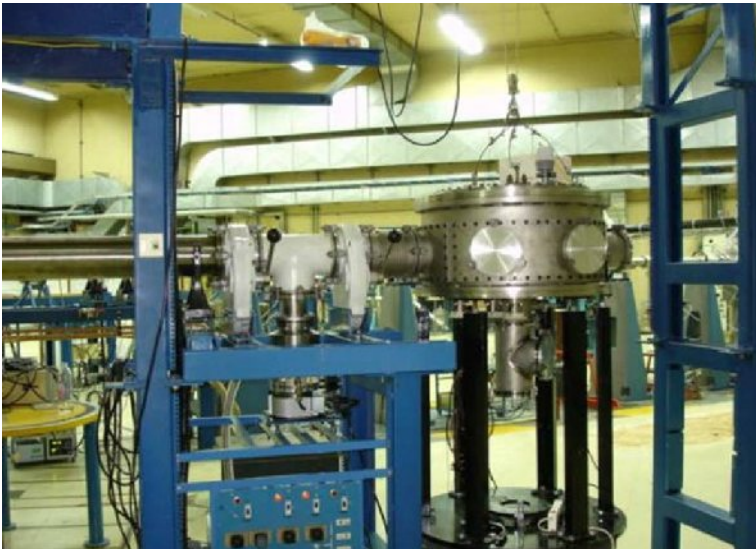
Figura 12. Línea EDRA. Fuente: Departamento Energía Solar, Gerencia Investigación y Aplicaciones, CAC-CNEA.
