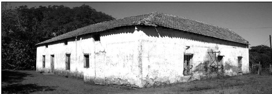
Figura 2. Vista del estado actual de la Casa de la Administración.
