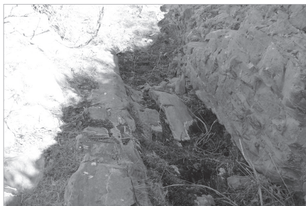
Figura 9: Roca de basamento cortada para el encauzamiento del agua.
