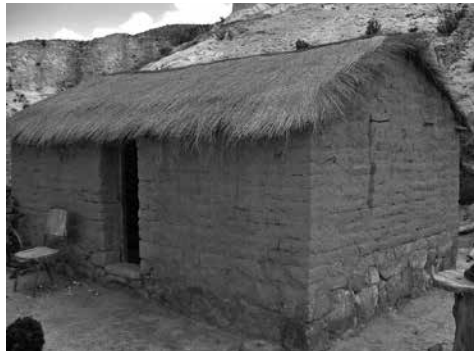
Figura 8: Techo con la cubierta de guaya recién terminada, donde se distingue el giro que se le da a los manojos de paja para armar los aleros. Fotografía: Jorge Tomasi
