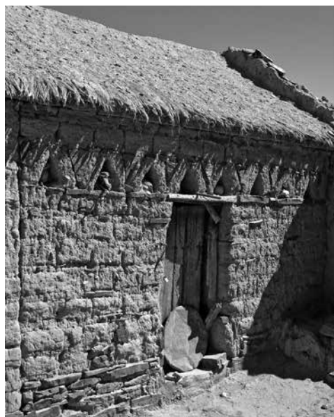
Figura 6: Detalle de un muro de adobe por encima del sobrecimiento de piedra. En tanto se trata de una cocina, se distingue el trabajo para generar las aberturas de ventilación.
