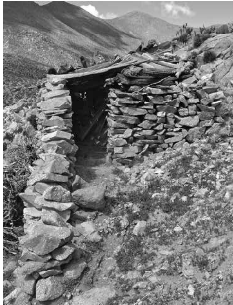
Figura 2: Recinto cubierto en una estancia construida aprovechando un alero de piedra y con un cerramiento en pirca seca. Fotografía: Jorge Tomasi
