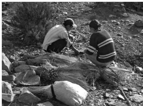
Figura 9: Proceso de preparación de la paja para su posterior uso en la cubierta. Fotografía: Jorge Tomasi
