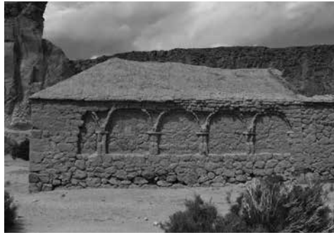
Figura 7: Muro de adobe con arcos realizados con los mismos bloques a modo de ornamentación de la casa. Fotografía: Jorge Tomasi
