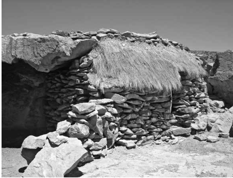
Figura 2: Recinto cubierto en una estancia construida aprovechando un alero de piedra y con un cerramiento en pirca seca. Fotografía: Jorge Tomasi
