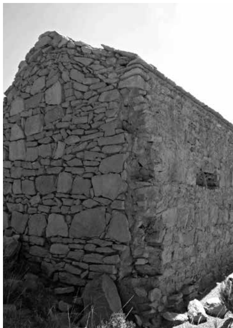
Figura 4: Detalle del trabajo de un muro con la traba de las piedras de diferentes dimensiones.
