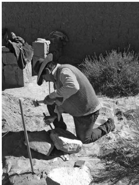
Figura 5: Un momento en el proceso de canteado de la piedra para los sobrecimientos.
