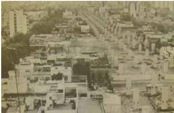
Figura 3. Demoliciones para la construcción de autopistas. Fuente: Zicovich Wilson, 1983, p. 66.
