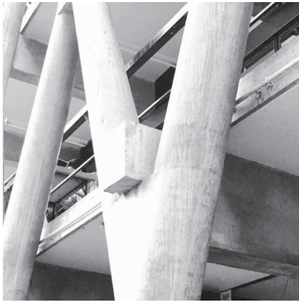
Fig. 4 Detalle de nudo cojinete
