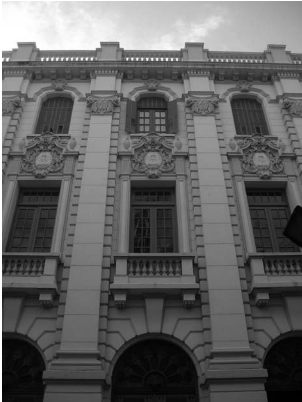
Figura 6. Frente de la Legislatura de Córdoba. Fotografía: Ana María Martínez de Sánchez.
