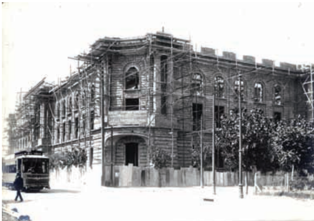
Anónimo. Construcción del edificio para la Aduana Argentina, 8 de febrero de 1910. (Universidad Pablo de Olavide, Chile)
