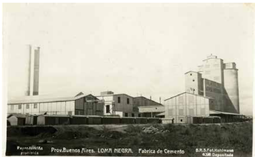
Fabrica de cemento Loma Negra, Buenos Aires, circa, 1930. "En 1928 el terrateniente Alfredo Fortabat fundó Loma Negra, y la familia Minetti, propietaria de molinos, fundó la Compañía Sudamericana de Cemento Portland al año siguiente." Fuente: Biblioteca Nacional
