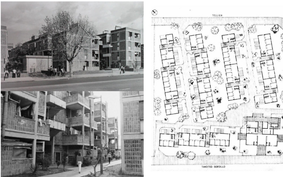
Imagen 5. Fotos de conjunto y planta baja general Barrio Justo Suarez
