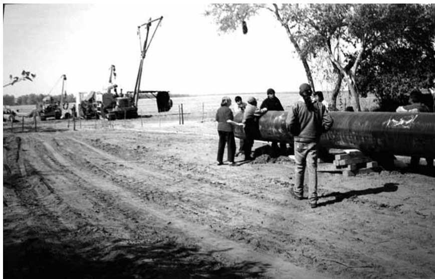
Desmante y gasoducto en territorio comunitario. Fuente: comunidad Wichí Mataco
