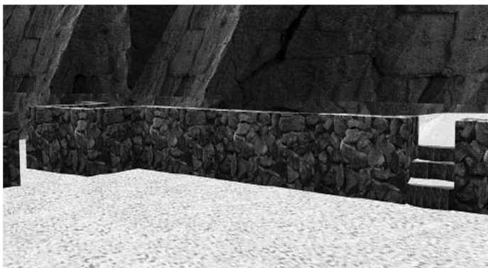
Vista a ojo humano de otro edificio del abra. Se observan dos accesos, uno con escalinata.
