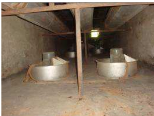
Figura 3 - Ventiladores de 1,5HP (izquierda), ventilador axial de 20 HP (derecha).
