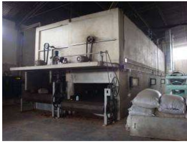
Figura 1 – Vista del secadero desde la zona de descarga de los productos deshidratados.
