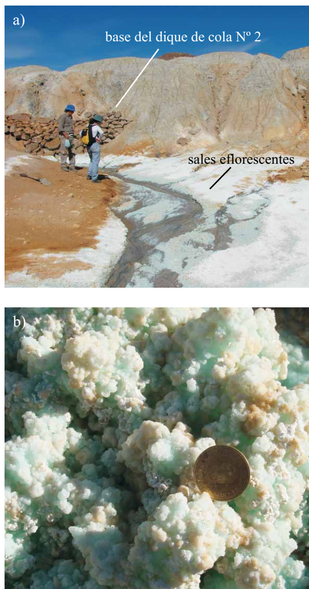
Figura 11. Sales eflorescentes en el pasivo Minero Pan de Azúcar. a: base de DC2. b: detalle de las sales.
