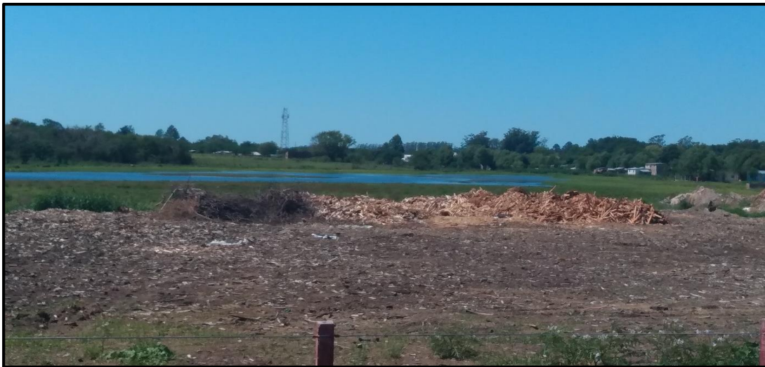
Fig. 5: Fotografía del relleno de la cubeta de la laguna Correa (Bella Vista, Corrientes) Fuente: Fotografía de Silvia Evangelina Martínez. (22/11/2020)
