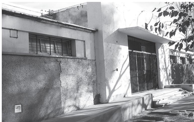
construcción tridimensional de los espacios. Las aulas seleccionadas A2 y A3 presentan tipología de bloque compacto de 7.95m x 6m x 3.86m (47.7m<sup>2</sup>) con un sistema de aventanamiento bilateral, sin dispositivos de control solar (Figura 3). El sistema de iluminación artificial complementario instalado es de 6 artefactos —2 tubos fluorescentes T8 de 36 [w] cada uno de 4300°K (luz neutra), sin pantalla difusora. Asimismo presentan en la Tabla 1 sus cualidades distintivas.
