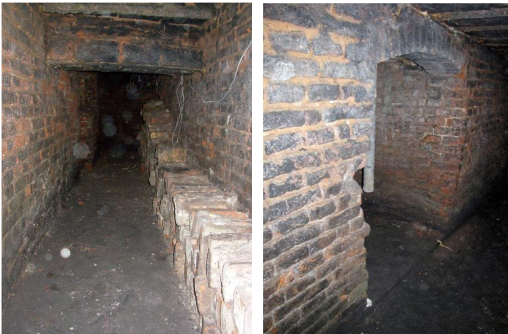
Las primeras galerías de la Usina en su primera etapa, cuando sólo generaba electricidad (fotos 2011).
