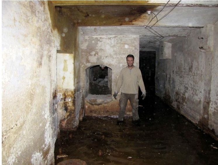
Una de las cámaras bajo tierra para conservar agua bajo la antigua Usina (foto 2011).
