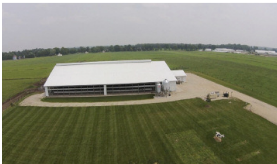
Tambo robótico de la Michigan State University. La unidad consiste en un galpón de tipo freestall con robots Lely Astronaut 3 en tráfico libre y con acceso a pasturas mediante puertas selectoras inteligentes.
