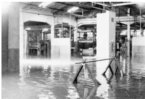
2-3. Exterior e interior de la Algodonera Flandria durante inundación, año 1985 (Fuente: Archivo fotográfico Algodonera Flandria)
