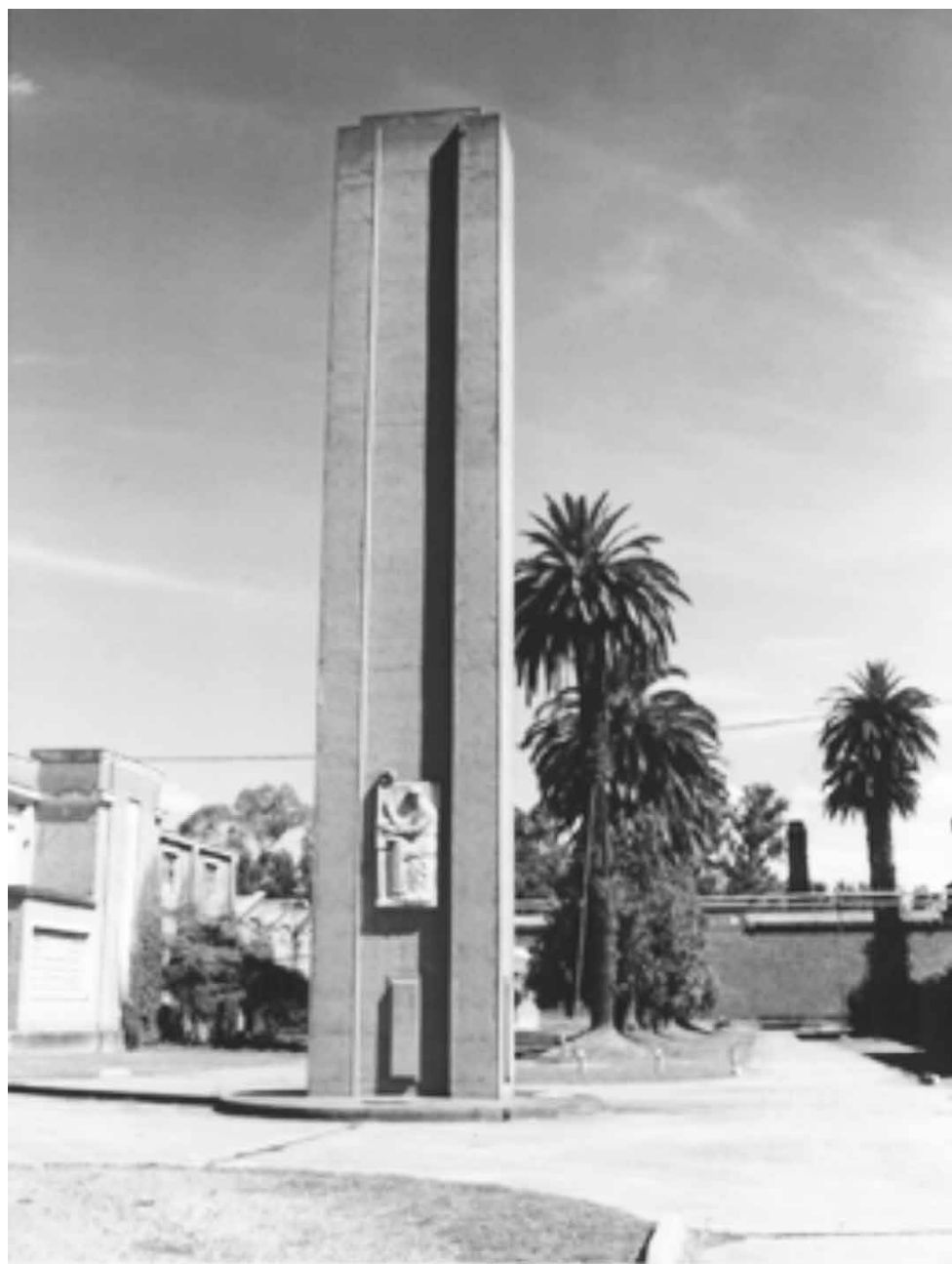
Monumento a las enciclicas Monolito en concreto, mortero rojo con aplicaciones. Tamaño: 12,00mX3,00mX1,50m Ubicación: Parque industrial Algeciras Flandria
