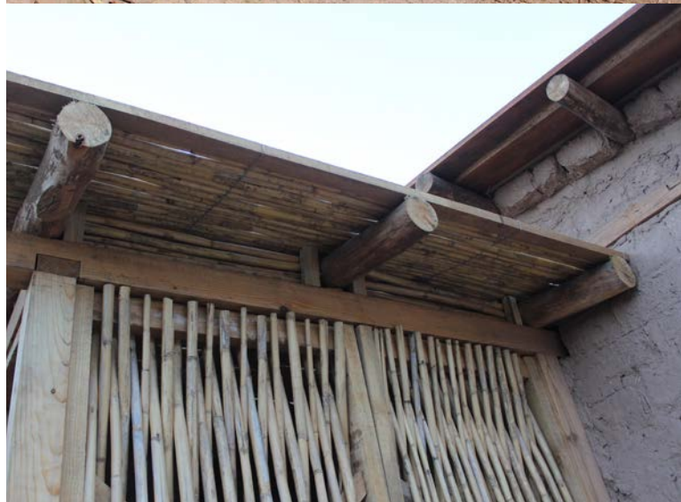
Detalles de construcciones con quincha reforzada
