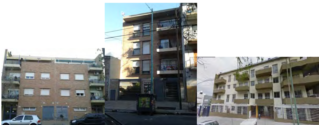
Imagen 4: Fotos de fachadas de Complejo Estomba 1148, Giribone 840 y Virrey del Pino y Donado. PRTEExAu3. CABA. 2013. Fuente: Relevamiento fotográfico propio.
