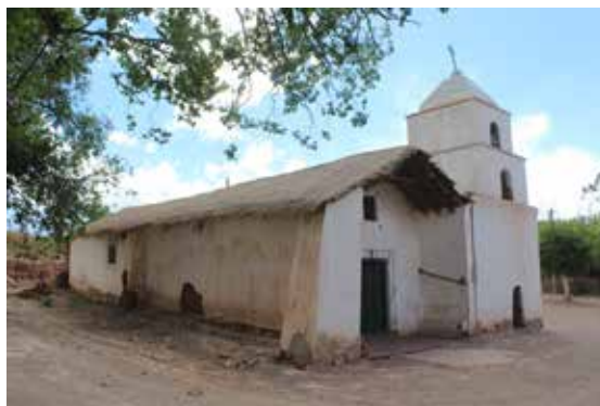
Figura 3. Vista de la Iglesia de Tabladitas. Fotografía: autores.
