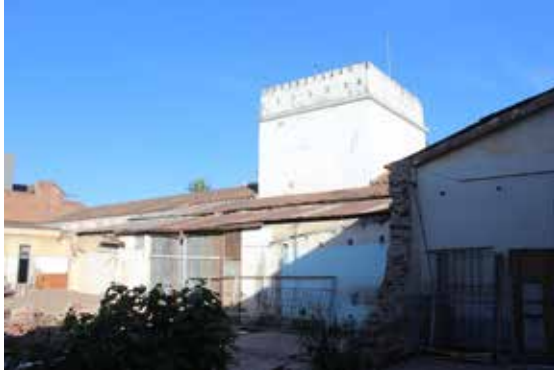
Figura 4. Vista de la torre del Cabildo desde el patio. Fotografía: autores.
