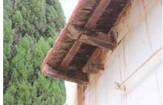
Figura 14. Armado de los aleros en la Iglesia de Uquía. Fotografía: autores.
