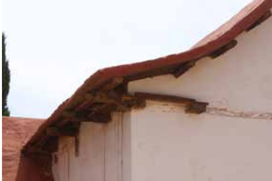
Figura 13. Detalle de los extremos de la viga collar en la Iglesia de Uquía. Fotografía: autores.
