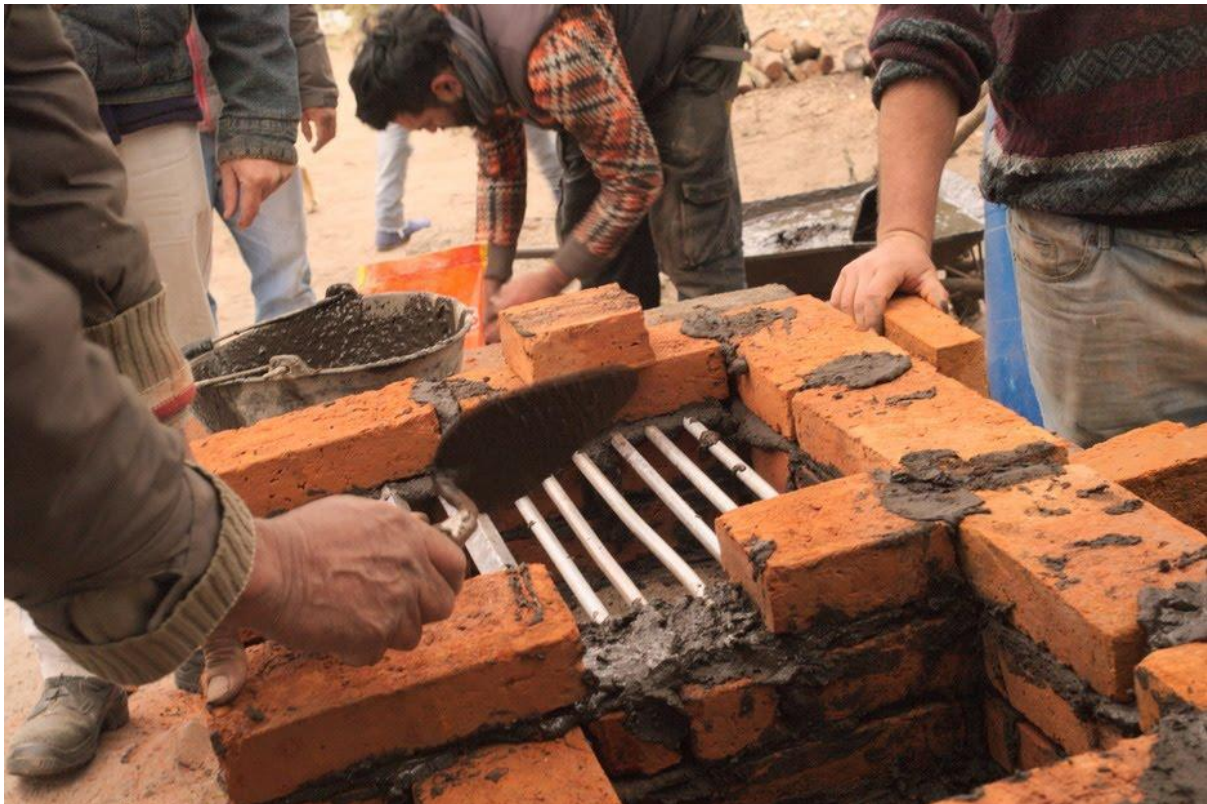
Imagen 1. Hacer colectivo: la puesta en diálogo de conocimientos constructivos locales.
