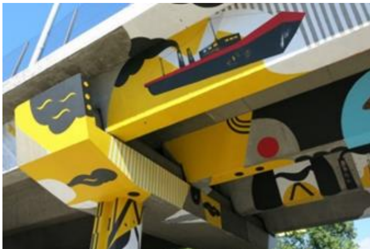
Figura 4. Bajo-autopista en las calles Herrera y California. Fuente: Sitio Web GCBA, 2018.
