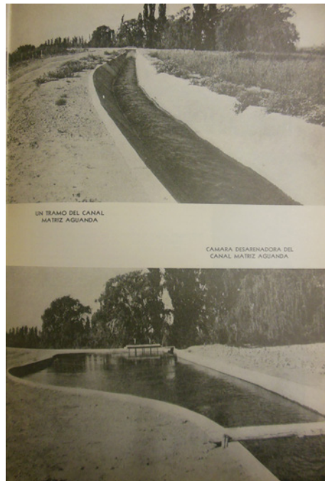
Figuras III: Obras en el canal Santa Rosa (Mendoza) y en el canal matriz Aguanada (San Rafael). Fuente: Gobierno de Mendoza (1949). Agua, Vivienda y Salud, Mendoza, Ed. Oficial, p. 52 y ss..
