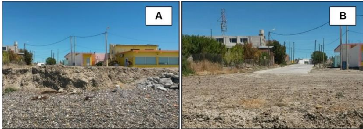
Figura 10. Registro fotográfico Sector 6
