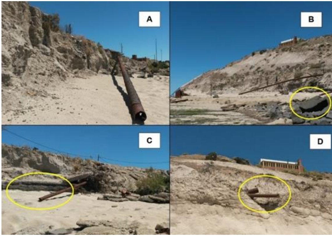
Figura 6. Registro fotográfico Sector 2
