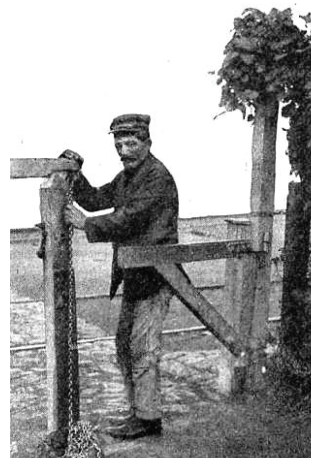
Figura 7. Guardavía cerrando las barreras
