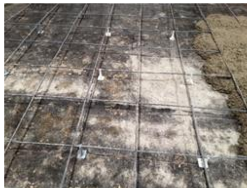
Figura 10. Losas con refuerzo de barras de acero.
