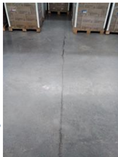
Figura 4. Fisuras por asentamiento plástico. Foto: Fisura en la línea de una barra de refuerzo.
