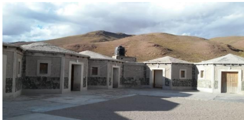
Figura 2: Vista de la escuela desde el patio interior
