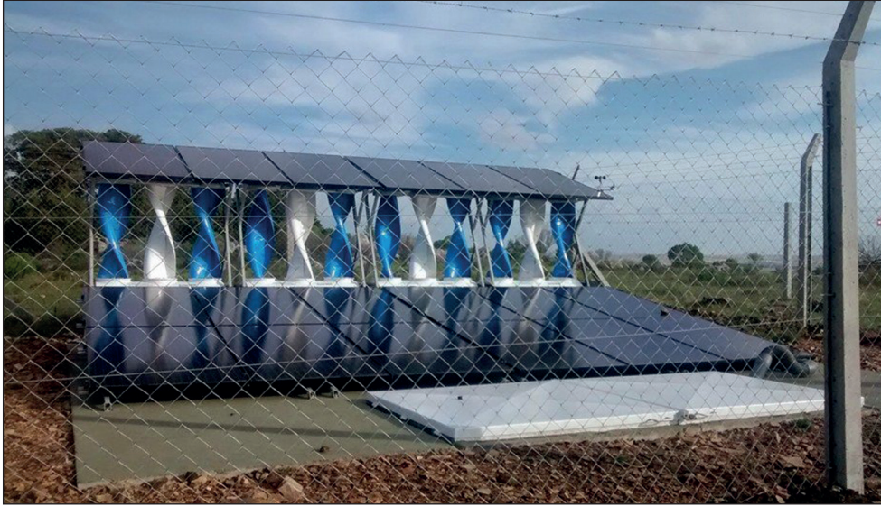
Foto 2. Sistema híbrido eólico-solar en el Cristo de las Sierras, Tandil (Buenos Aires)
