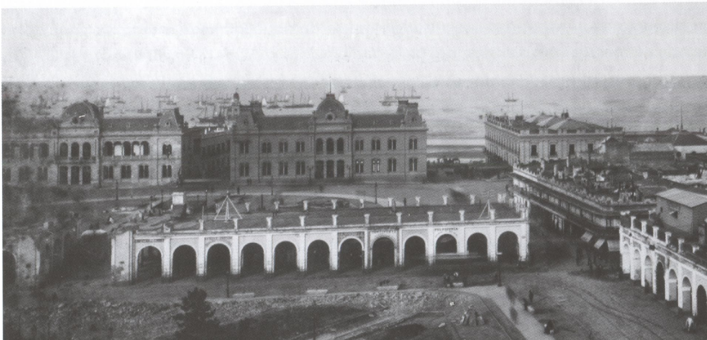
Figura 10 Foto de Alejandro Witcomb de la Plaza de Mayo y la Recova antes de su demolición, 1888.
