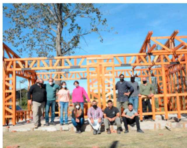
Sistema constructivo en madera de álamo. Fuente: Proyecto de investigación PICT START UP 00013-MINCYT
