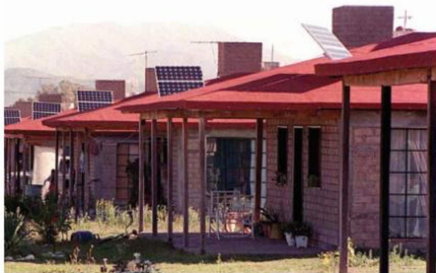
Barrio ECOSOL, realizado con BTC (Bloque de Tierra Comprimida), Salta. Proyecto: Arq. Polliotto e Ing. Galíndez.
