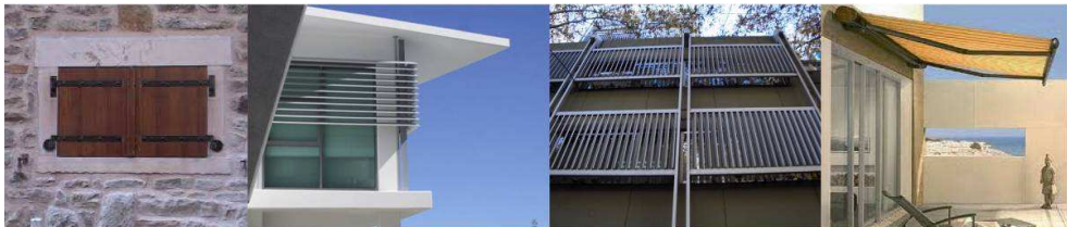
Figura 20: postigo. Figura 21: estantes de luz horizontales. Figura 22: estantes de luz verticales. Figura 23: toledo.
