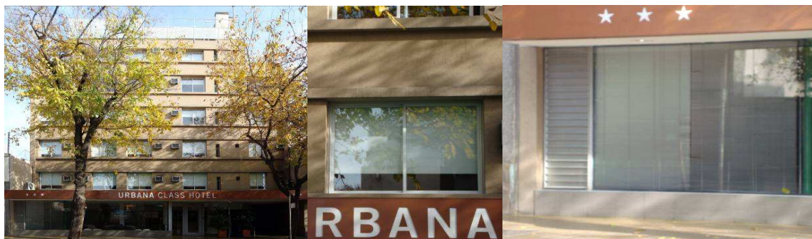
Figura 7: panorámica. Figura 8: detalle, cortina de tela de enrollar interior. Figura 9: detalle, veneciana interior.
