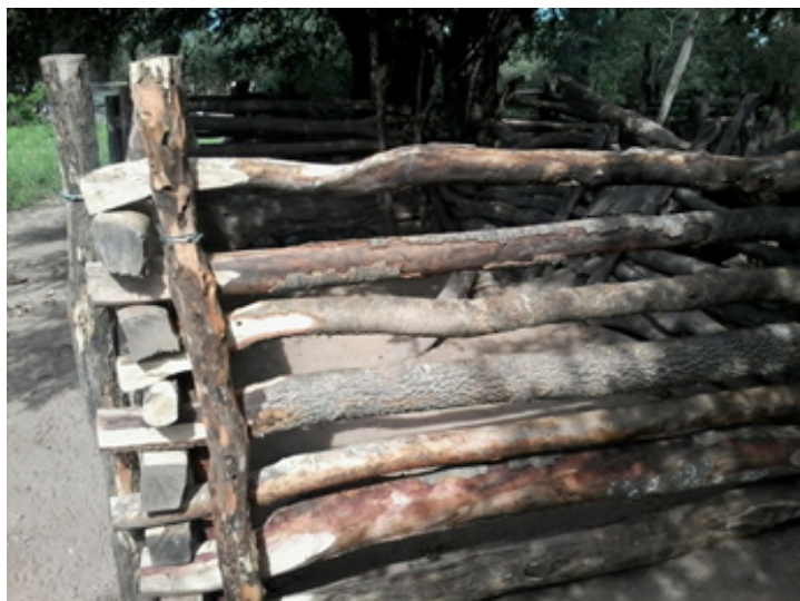
Imagen núm. 6 Columna lateral construida con dos postes de Quebracho colorado
