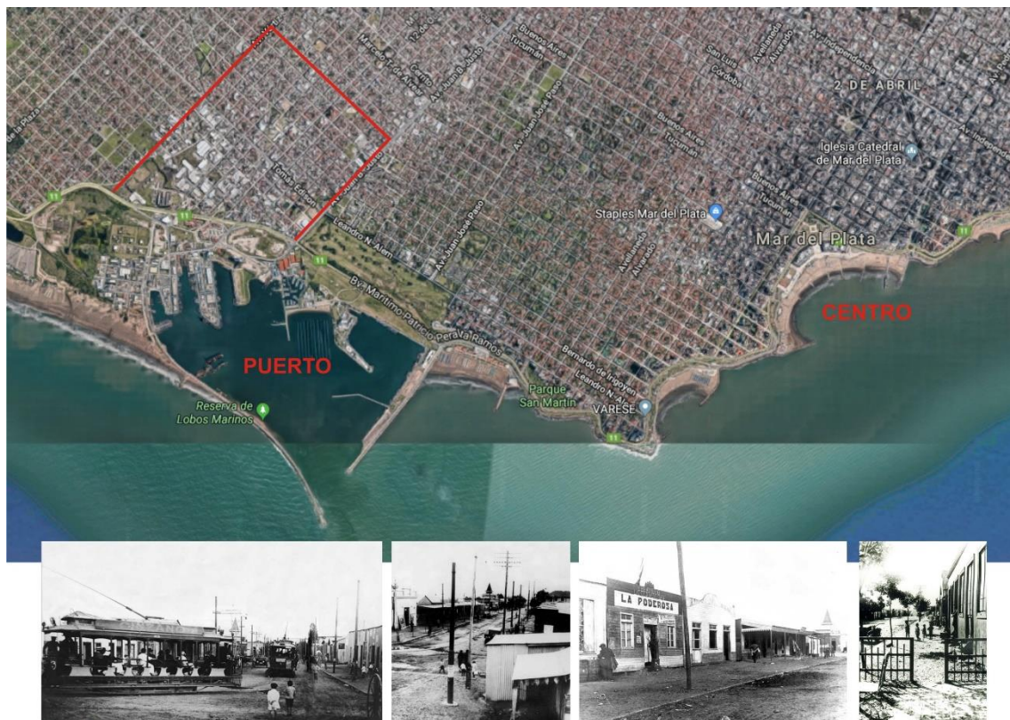
Figura 2. Área puerto en relación al centro de la ciudad y paisaje urbano a principios del siglo XX.
