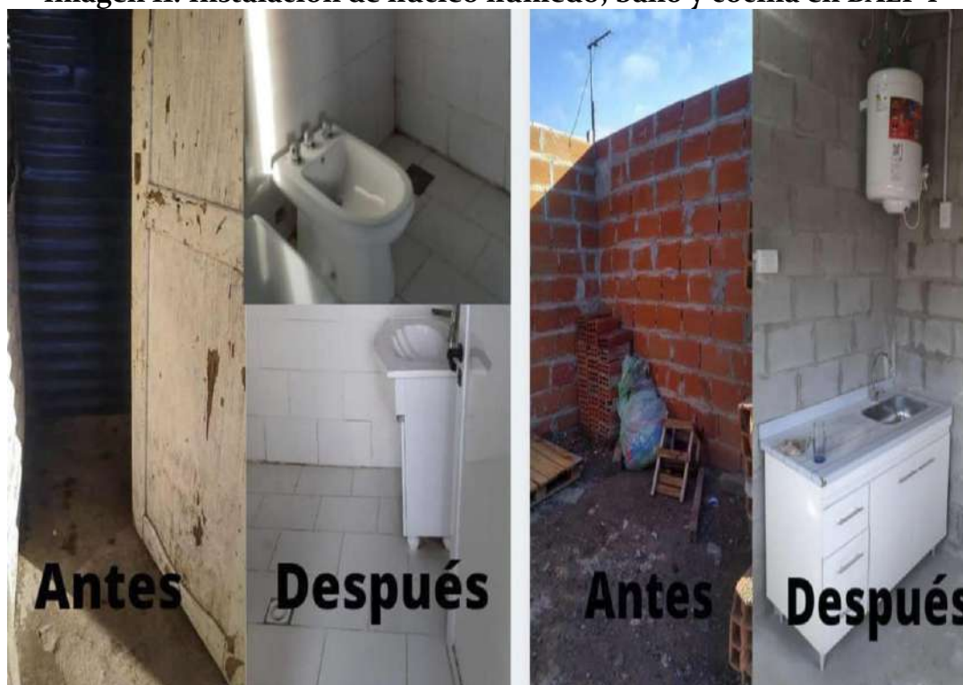
Imagen 11. Instalación de núcleo húmedo, baño y cocina en BALP I
