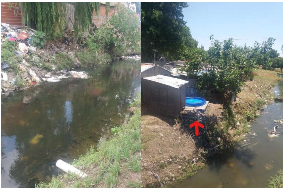
Imagen 2: Salida de desagüe al arroyo de las viviendas del BALP I. Esta imagen se repite a lo largo de todo el barrio. Febrero 2020
