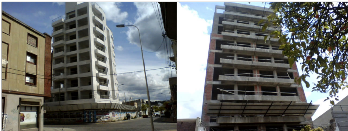
Imagen 1. Izquierda: edificio en construcción Irigoyen Plaza (Bértoli Constructora); Derecha: edificio en construcción Prestige 12 (Grupo ZYASA). Tandil, 2015
