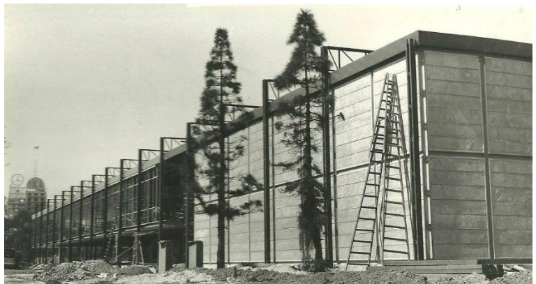
Figura 6. Los paneles de hormigón alveolar que envuelven el microcine hacen del tratamiento superficial, referido a encofrados metálicos y prefabricación, un elemento expresivo de su fакtura y tienen un ritmo que se contrapone al de la estructura.
