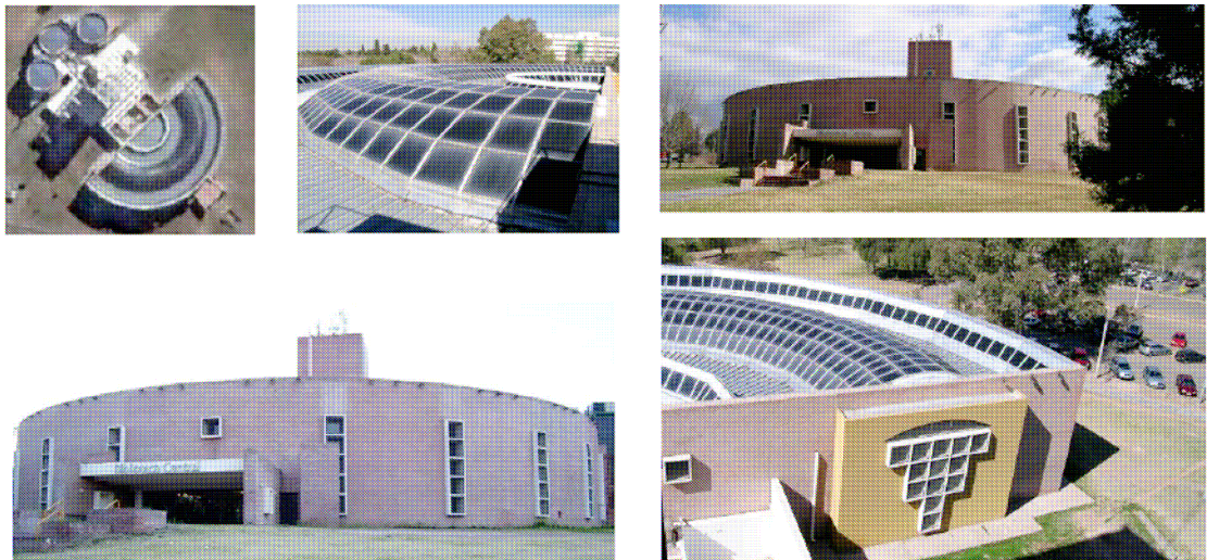
Figura 4. Fotos con vistas del edificio de la biblioteca
