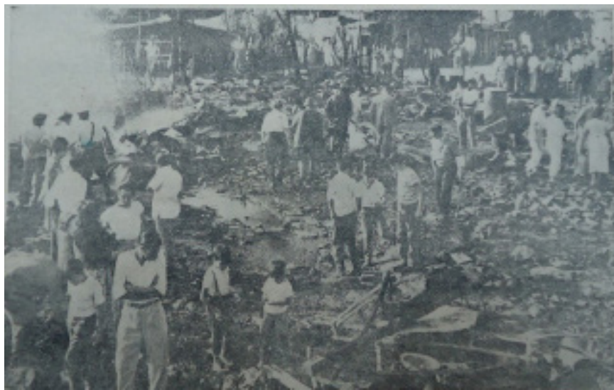
Figura 6. La Villa del Bajo Belgrano después de un incendio Fuente: La Hora (1958)
