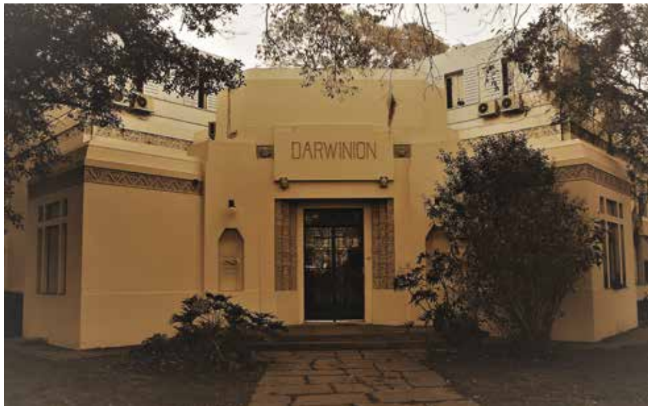
Fachada del Instituto de Botánica Darwinion, San Isidro, Buenos Aires. Foto: Osvaldo Morrone.
