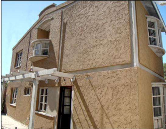
El prototipo utiliza un sistema constructivo UMA que combina la producción en taller de componentes metálicos (vigas y columnas) y pre-moldeadas de hormigón (cerramientos laterales, entresijos y ventanas), con el armado en obra de la estructura del prototipo, la ejecución de las paredes, el hormigonado de la fundación, el techo y el completamiento interior y exterior.
