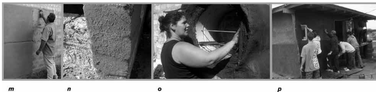
Figura 5. Elementos alternativos para revocos y terminaciones. Prototipos construidos en: Bancalari (m); San Martín (n) e INTI Migueletes (o), en Buenos Aires; Nuevo Golf (p) en Mar del Plata. Fuente: Rodolfo Rotondaro.
