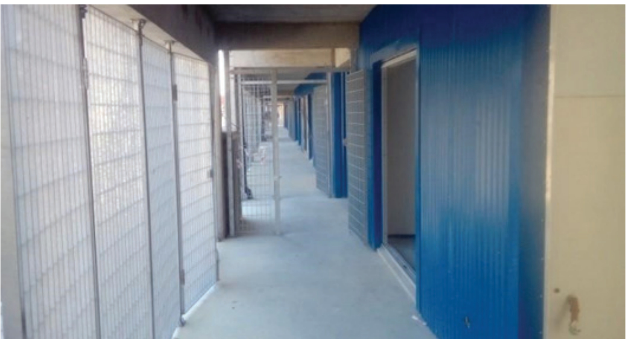
Figura 5. Vista del sistema de rejas
